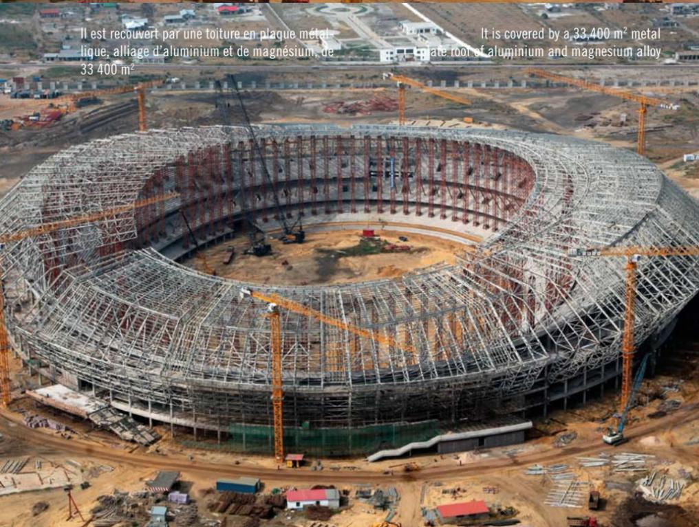
Il est recouvert par une toiture en plaque métallique, alliage d'aluminium et de magnésium, de 33 400 m<sup>2</sup>
