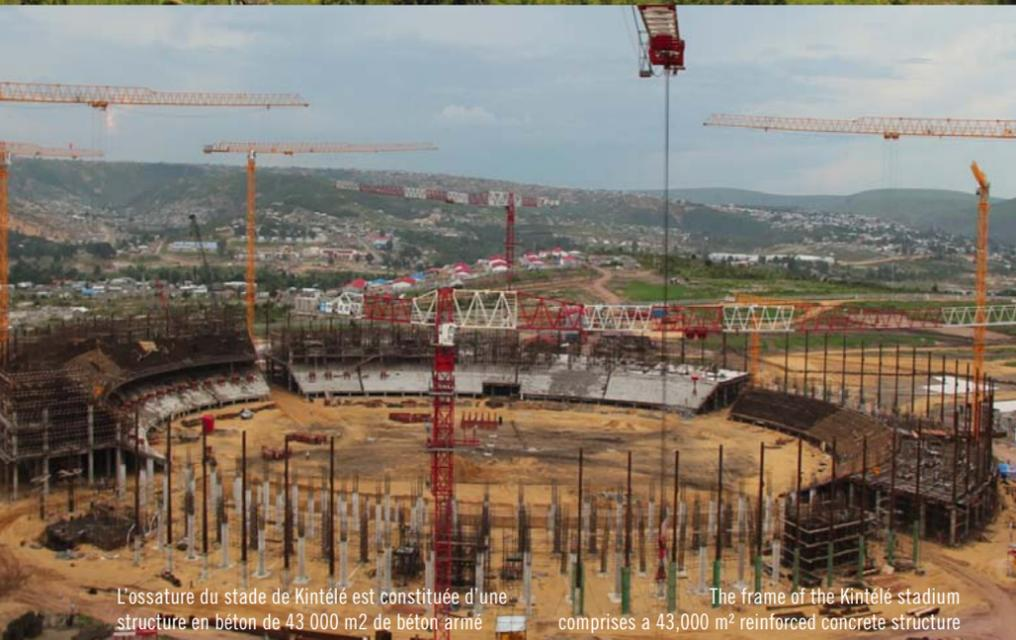
L'ossature du stade de Kintélé est constituée d'une structure en béton de 43.000 m<sup>2</sup> de béton armé
