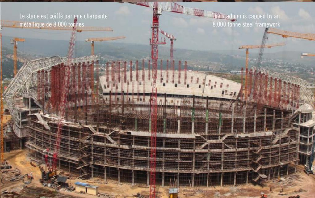
Le stade est coiffé par une charpente métallique de 8 000 tonnes
