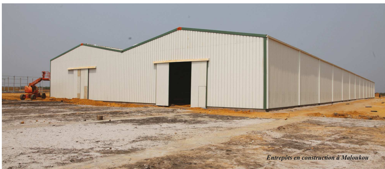
Entrepôts en construction à Maloukou (vue intérieure)
