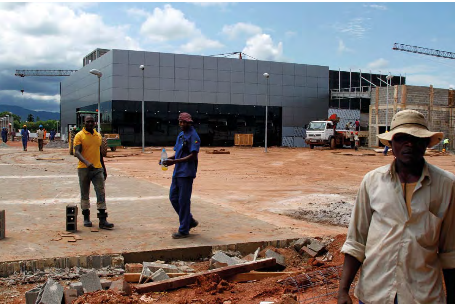
Chantier de l'hôpital de Madingou
