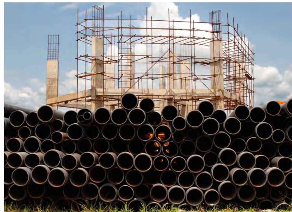
Chantier du château d'eau de Nkayi
