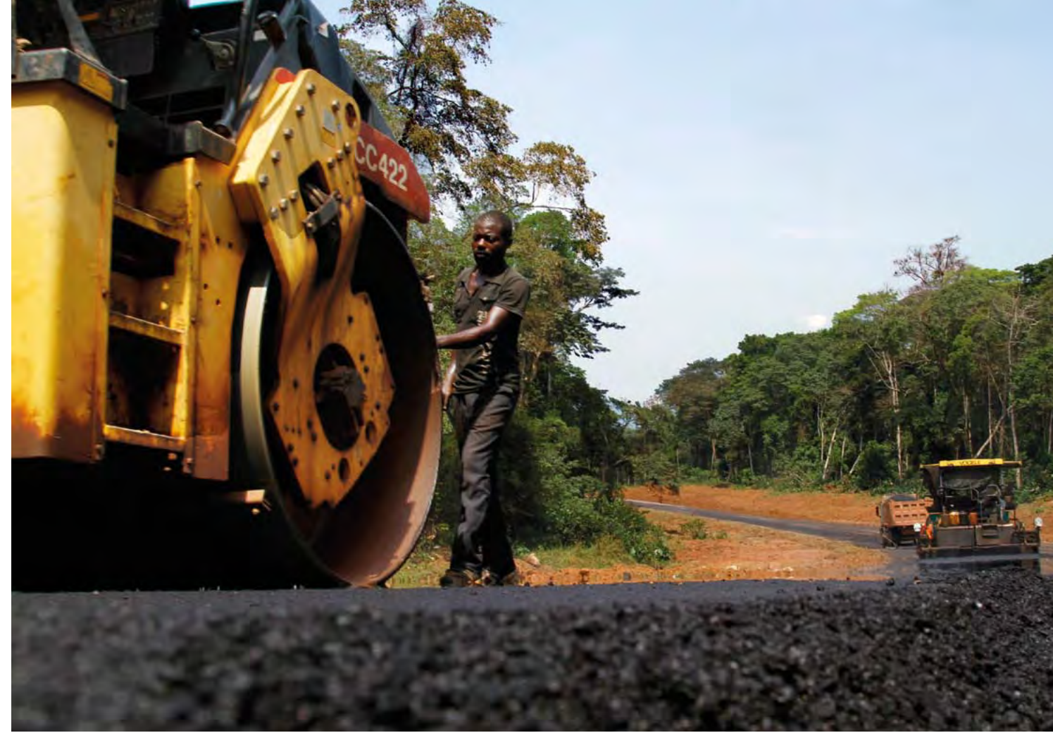
Un tronçon de la RN2, entre Mambili et Ouessou, en cours de bitumage en 2015
