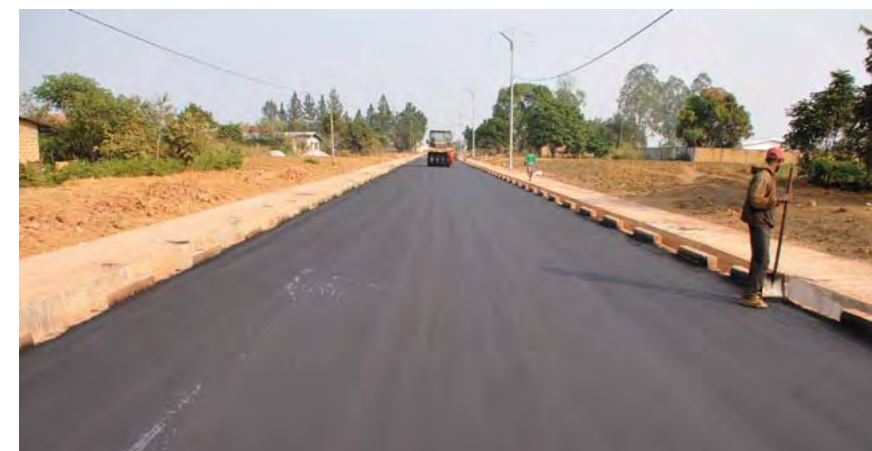
Une route en cours de bitumage à Djambala
