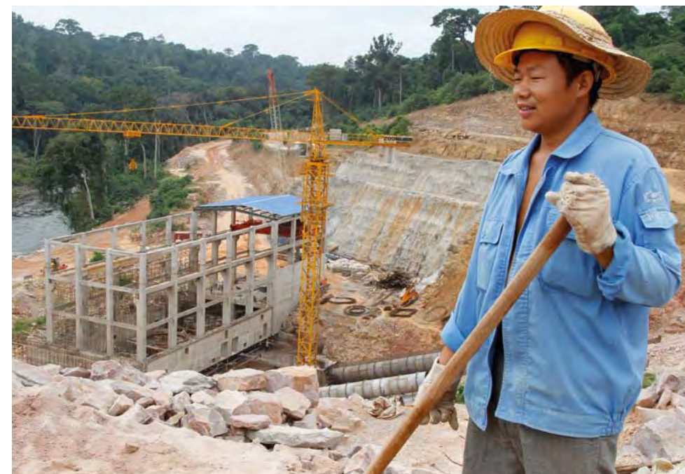
Un ouvrier sur le chantier de la centrale hydroélectrique de Liouesso
