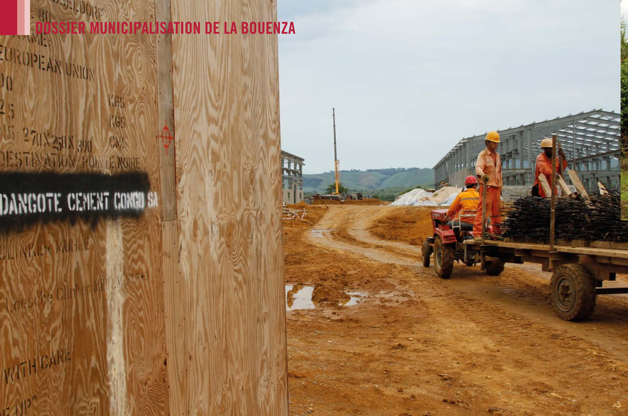
Chantier de l'usine Dangote
