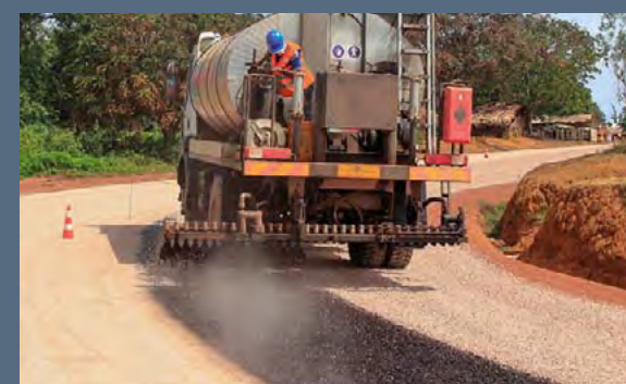
Utilisation de la solution de stabilisation des sols par Sipam Using Sipam, the surface stabilising solution
